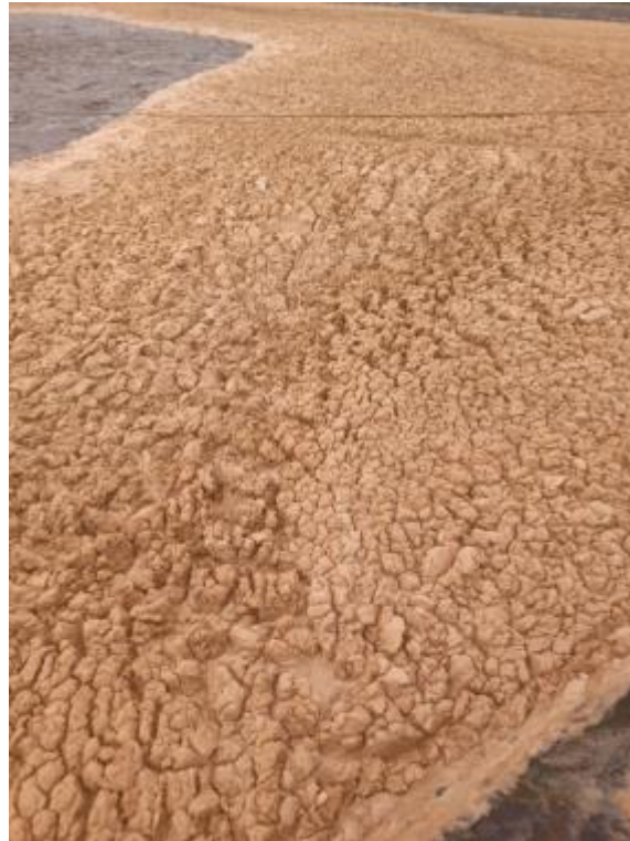
Figura 2: Espuma no tanque de aeração proveniente da indústria de carne suína.
