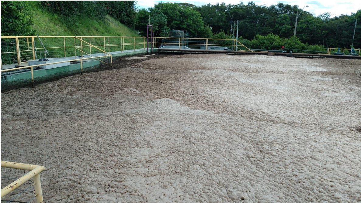
Figura 11: Espuma no tanque de aeração proveniente do esgoto doméstico.
