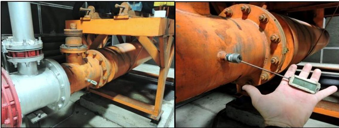
Figura 1: Detalhe da adaptação do termômetro na descarga do soprador de ar.
