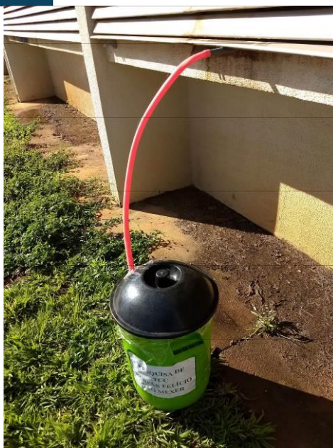
Figura 02 – Instalação do dreno para coleta de dados Fonte: Autor Próprio
