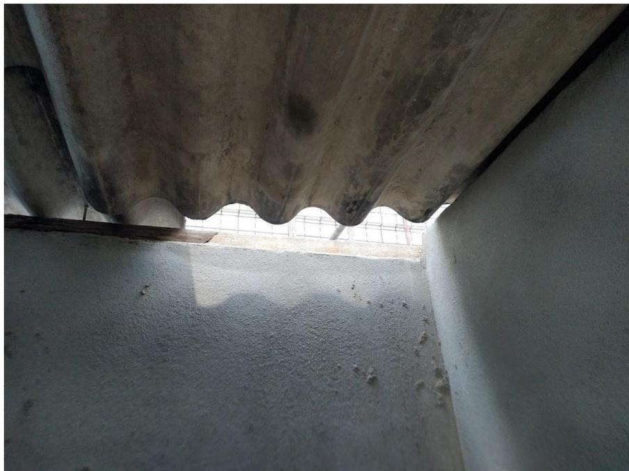
Figura 10. Abertura do telhado da casa da cisterna
