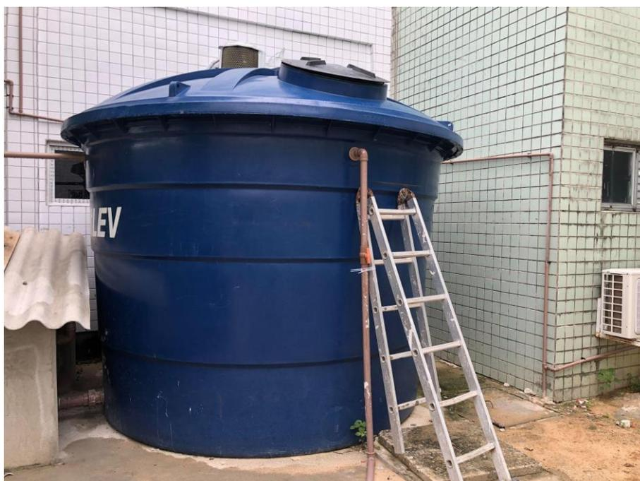
Figura 11. Novo reservatório de fibra
