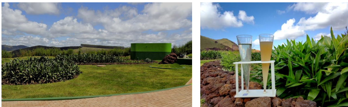
Figura 1: Imagem geral da ETE Wetlands (foto da esquerda). Efluente bruto e tratado pela ETE Wetlands (foto da direita).
