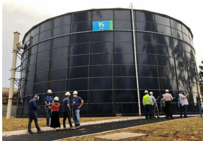
Figura 09 – Novo Reservatório Jd. Marilda. Metálico 10.000m3
