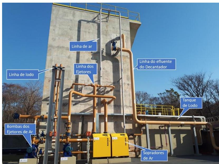
**Figura 3 – Vista Frontal do Biorreator Combinado (BRC)**
