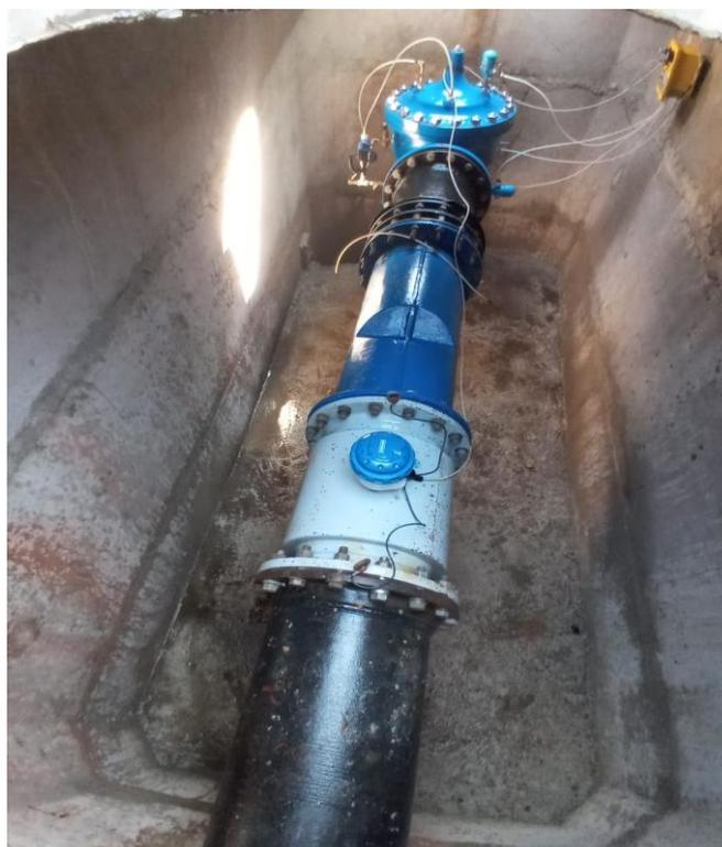
**Figura 02 – Registro fotográfico da VRP Paulo Guilguer – instalação dotada de sensores de monitoramento, controlador, VRP e macromedidor**
