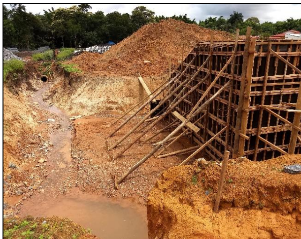
Figura 5: Controle de sedimentos no canteiro de obras.
