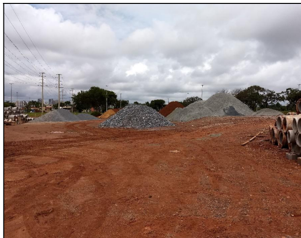
Figura 4: Manejo de resíduos sólidos da construção civil.
