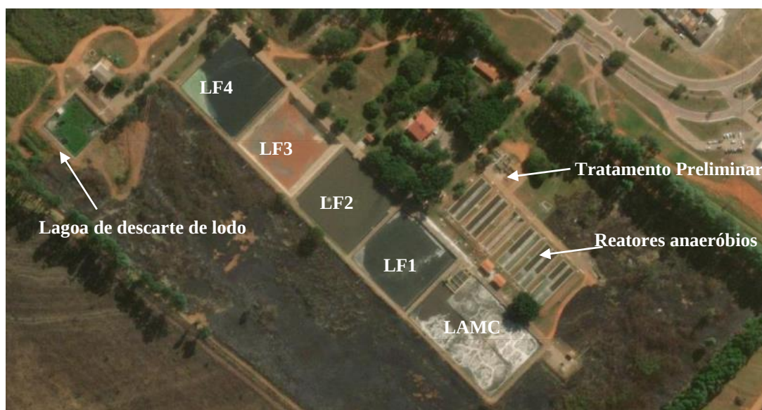
Figura 4 – Unidades da ETE Recanto das Emas
