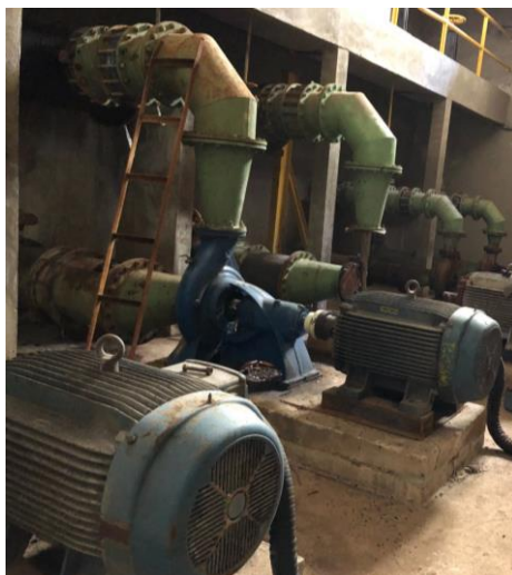
Figura 1: Sistema de bombeamento antes da intervenção
