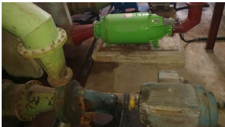
Figura 2: Sistema de bombeamento após a substituição
