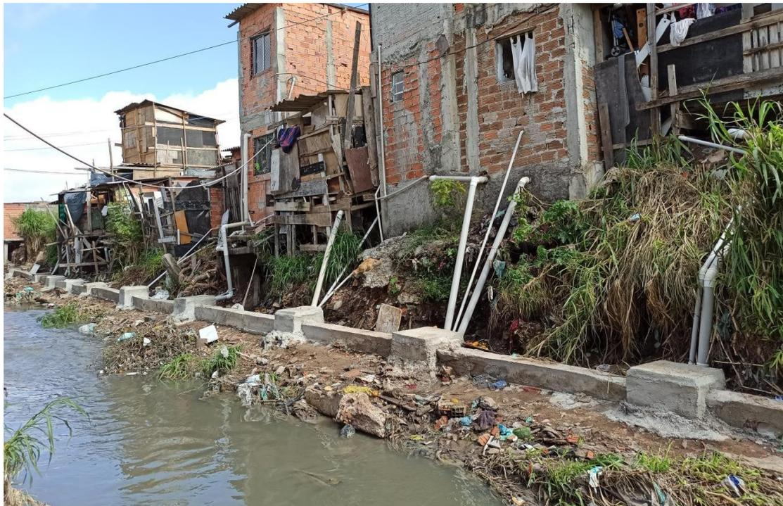
**Figura 8: Sistema de Coleta de Efluentes implantado em uma das 33 Comunidades (Vietna) - Ação das Águas Espreadas/Bacia do Rio Pinheiros/SP/BR (Arrecadação: Condomínio). Ação das Águas Espreadas/Bacia do Rio Pinheiros/SP/BR (Acervo: Consórcio DGF, 2021).**
