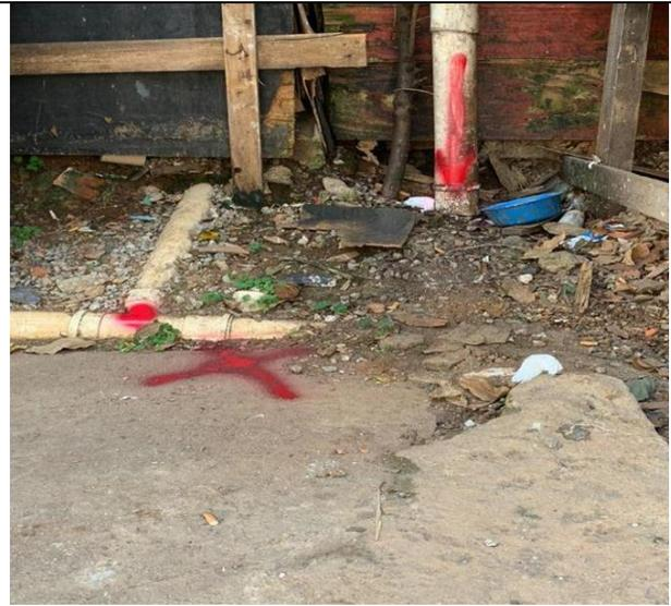
**Figura 5: Projeto de Campo - Marcação de pontos para levantamento topográfico - Ação Águas Espreadas/Bacia do Rio Pinheiros/SP/BR (Acervo: Condomínio - 2020).**
