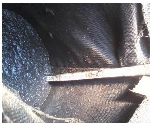
Fotografia 2 – Fita métrica instalada.
