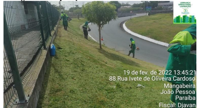
Figura 7 – Capinação manual em taludes
