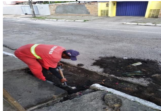
Figura 19 – Limpeza de boca de lobo
