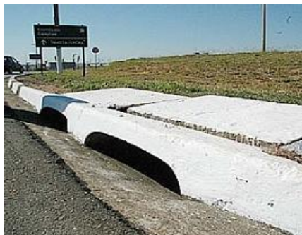
Figura 2: Estrutura de Drenagem em Ita – SC. Fonte: Autores (2023).
