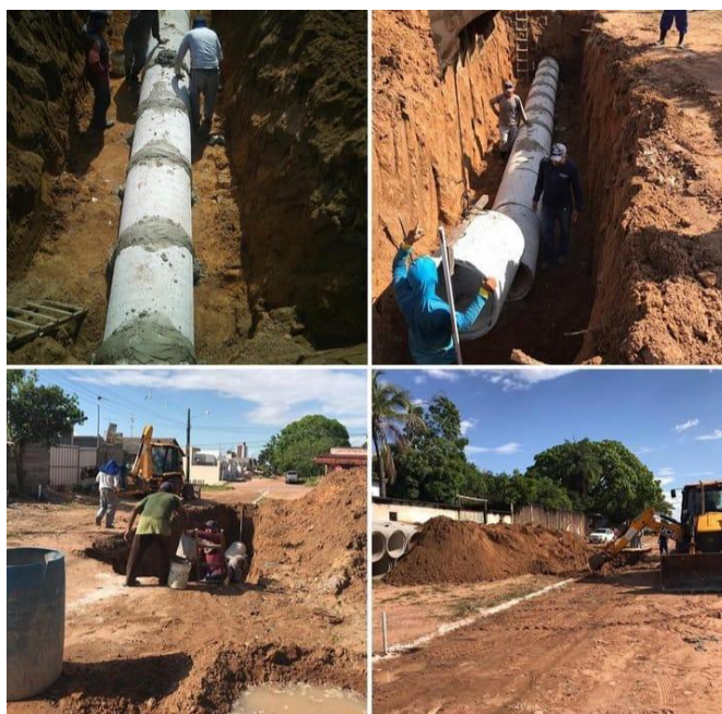
Figura 1: Obras de Drenagem em Limeira – SP. Fonte: Autores (2023).
