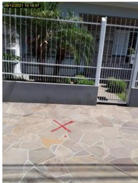
**Figura 10 - vazamento de ramal marcado no passeio**
