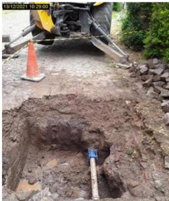
**Figura 11 - conserto de vazamento de rede**
