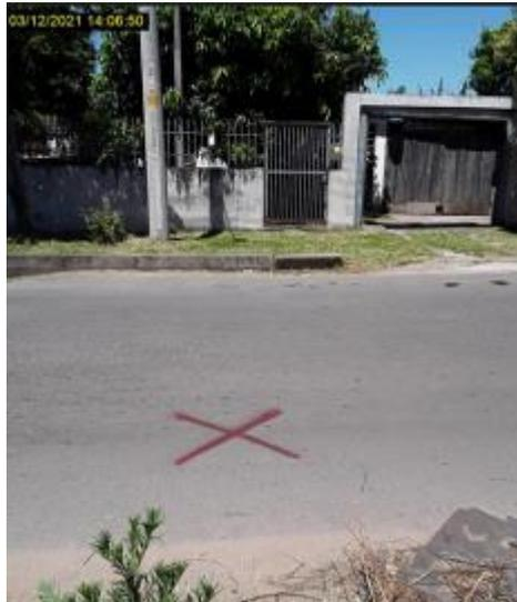
**Figura 9 - Vazamento de rede marcado na rua**
