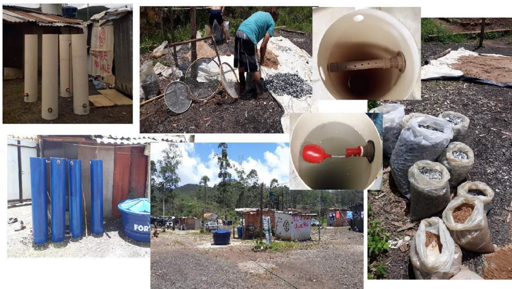
Figura 3: Imagens da montagem do sistema: tubos de PVC para os filtros; instalação de boias de nível nos filtros; tubo perfurado para drenagem de fundo dos filtros e limpeza dos meios filtrantes de diferentes granulometrias
