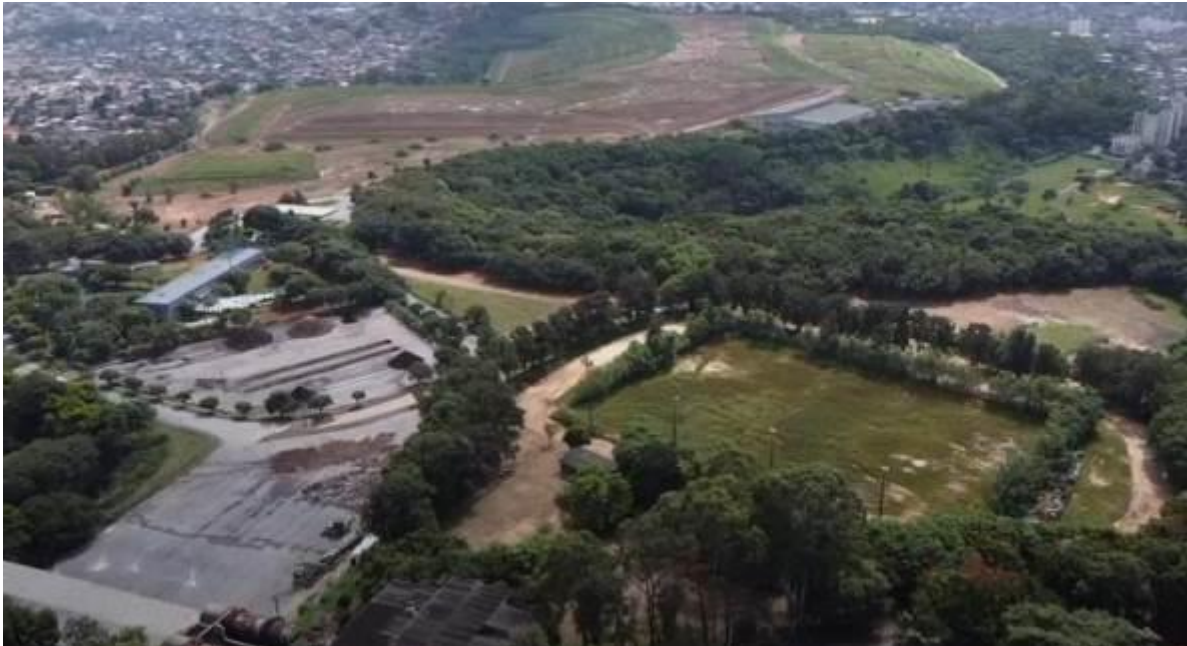
Figura 21. Imagem aérea da Central de Tratamento de Resíduos Sólidos da SLU (CTRS BR-040), 2021. Foto: Divulgação PBH.
