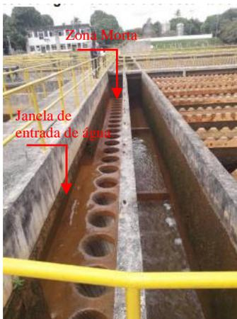
Figura 2: Acesso da água floculada ao decantador 2.
