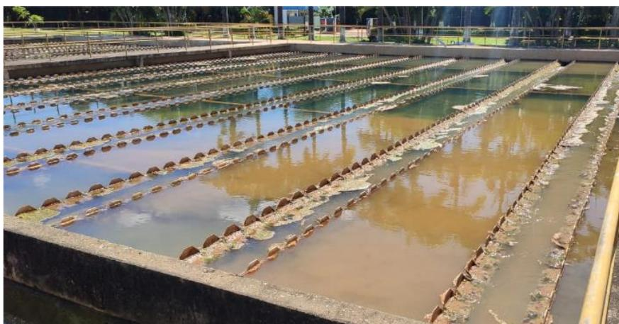
Figura 4: Ressuspensão de flocos no decantador 2.
