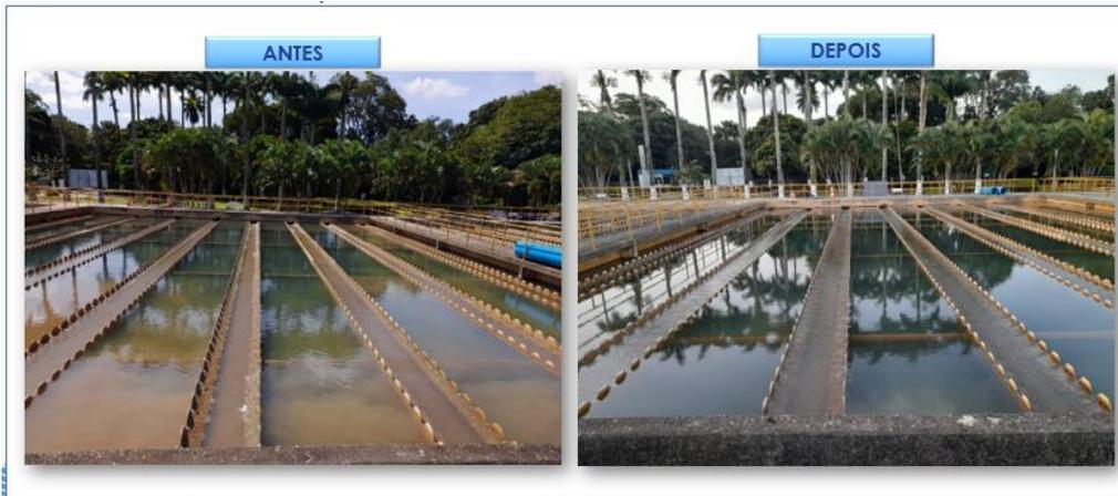
**Figura 8: Operação de decantador de alta taxa antes e depois da instalação de cortina de distribuição formada por tubos verticais perfurados.**
