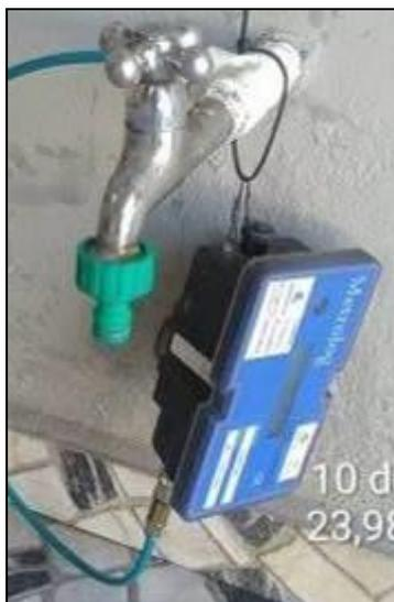
**Figura 12: Detalhes do local de instalação do Datalogger - Ponto 1 de Pressão.**
