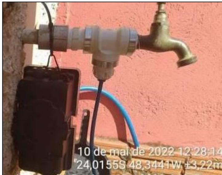
Figura 16: Detalhes do local de instalação do Datalogger - Ponto 3 de Pressão.
