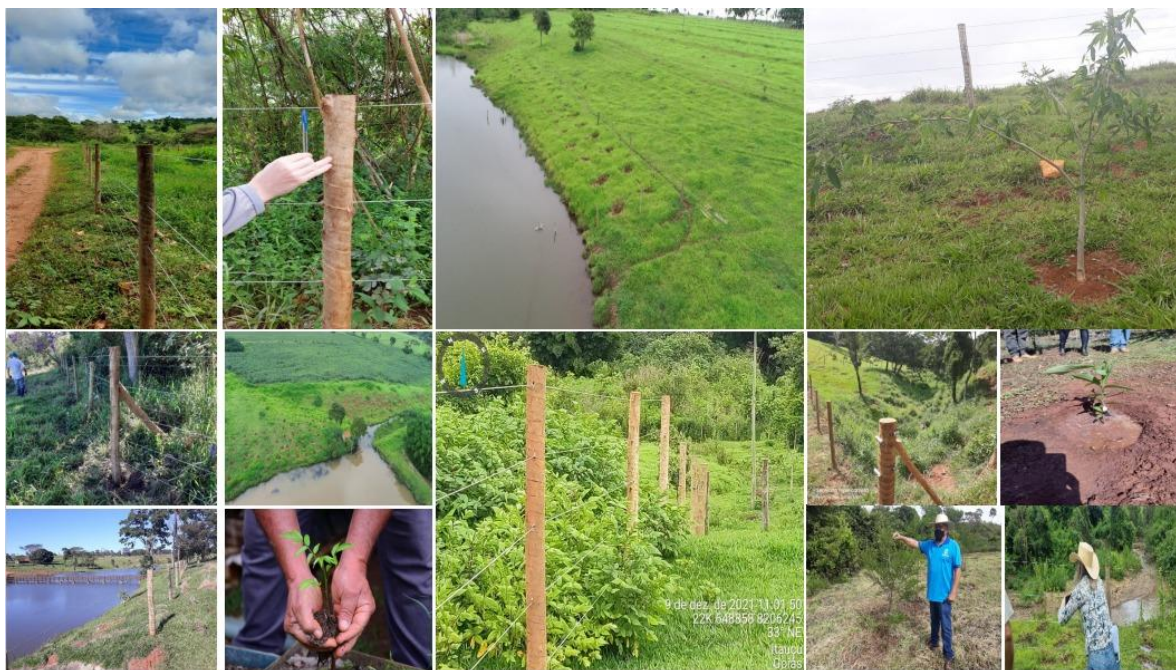
Figura 05 – Serviços de recuperação ambiental.
