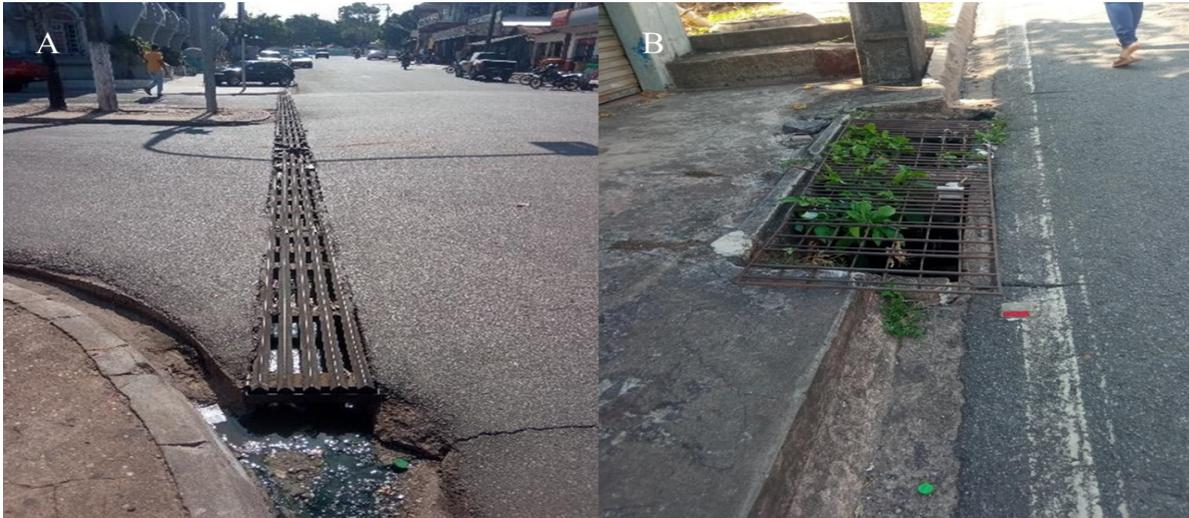
**Figuras 4A: Sarjetão; 4B Boca de lobo com grelha.**
