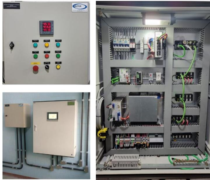
Figura 5 – Painel de Comandos Elétricos - PCE com Controlador Lógico Programável – CLP.
