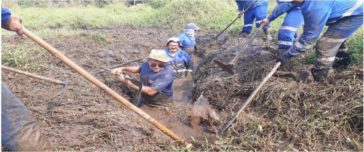
Figura 4. Aprofundamento e limpeza do canal principal.
