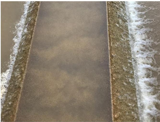
**Figura 1. Floculação ETA Nova antes da redução da dosagem**
