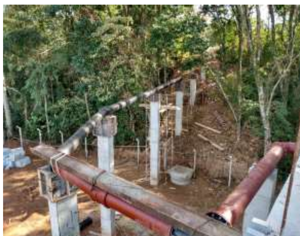
Figura 8 – Interligação da Tubulação de lodo de dentro do canal ao novo sistema de lodo
