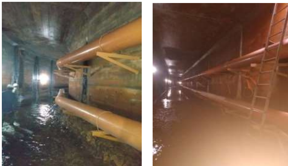
Figura 10 – Obra de canalização dentro do canal de água de lavagem dos filtros
