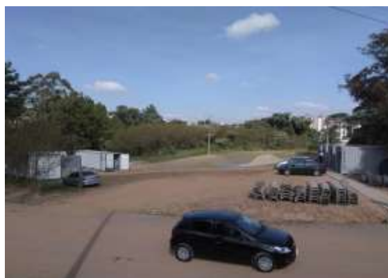
Figura 3 - Visão geral do canteiro
