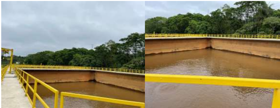
Figura 12 - Tanques de equalização de lodo
