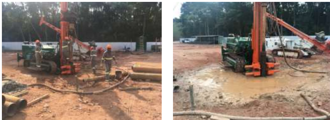
Figura 4 - Execução das fundações na área dos futuros tanques de lodo
