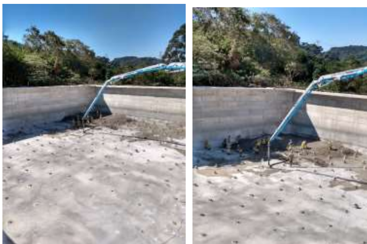
Figura 7 – Concretagem do fundo dos Tanques Equalização 2A e 2B
