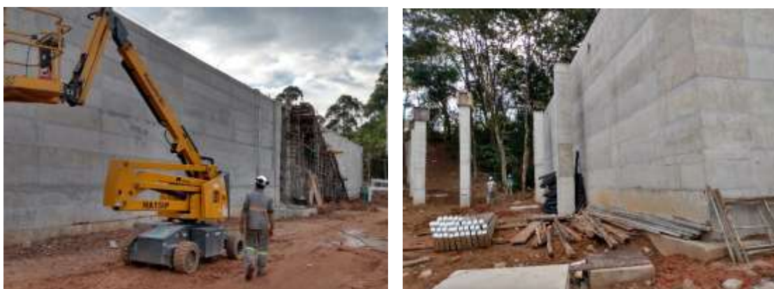
Figura 5 – Construção dos Tanques 2A e 2B
