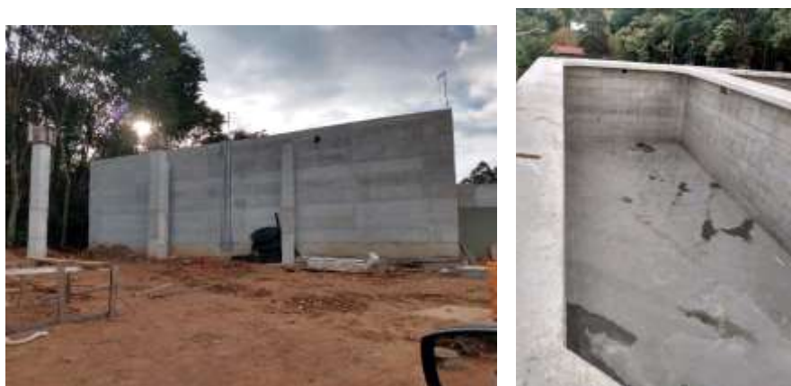
Figura 6 – Construção dos Tanques de Equalização 1A e 1B
