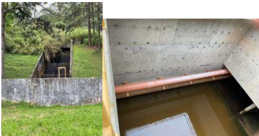
Figura 14 - Canalização do córrego
