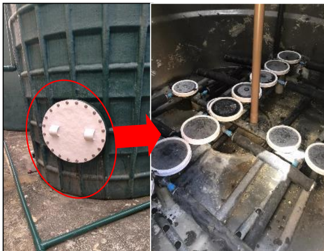
Figura 6 - Instalação de escotilha de visita e vista interna do sistema de distribuição de ar requalificado.
