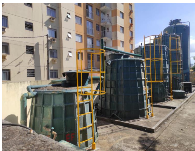
Figura 8 - vista da ETE com acessos requalificados.
