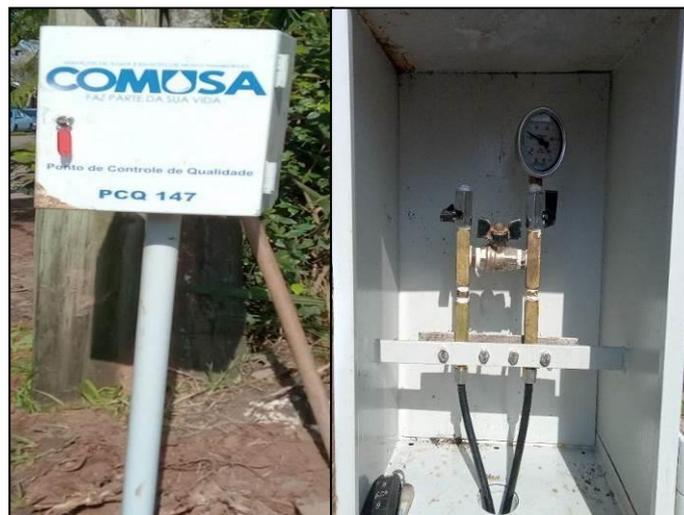
**Figura 4: Detalhe do sistema de dupla configuração de pressão dia e noite para VRP 59.**
