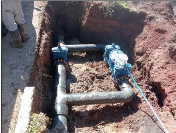
**Figura 3: Instalação da VRP 59, com espera para sistema de dupla configuração de pressão, manual.**
