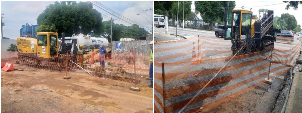
**Figuras 02 e 03: Perfuratrizes HDD na implantação da nova rede no município de Belém-PA.**
