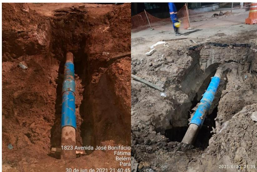
**Figuras 10 e 11: Rede de CA após manutenção de correção de vazamento no município de Belém-PA.**
