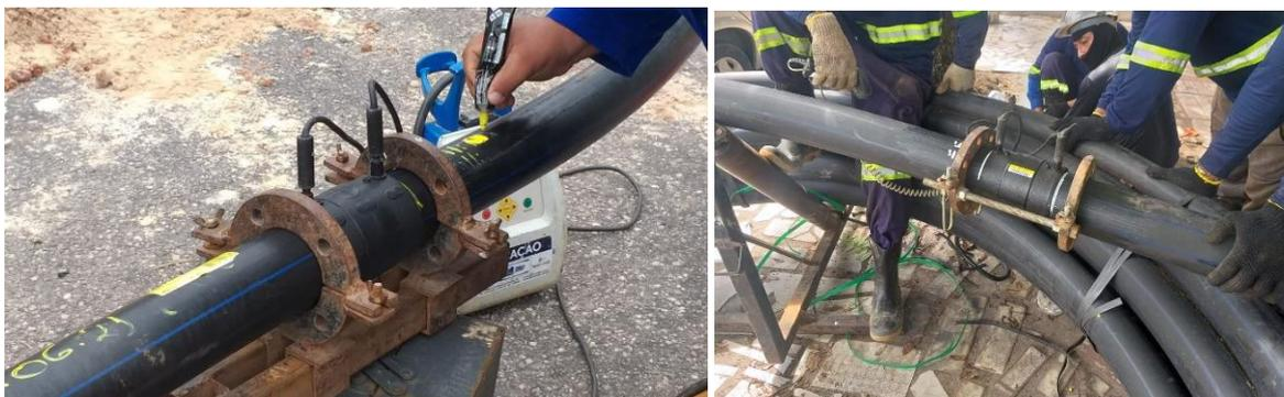
**Figuras 06 e 07: Registros da implantação de conexões de eletrofusão na rede nova no município de Belém-PA.**
