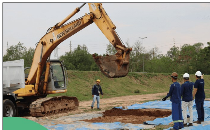
Figura 02: Biolodo sendo retirado da ETE Tijucal
