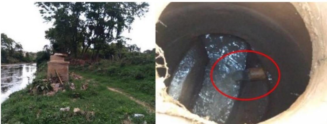
**Figura 3: Rede coletora com efluente de nascentes.**
