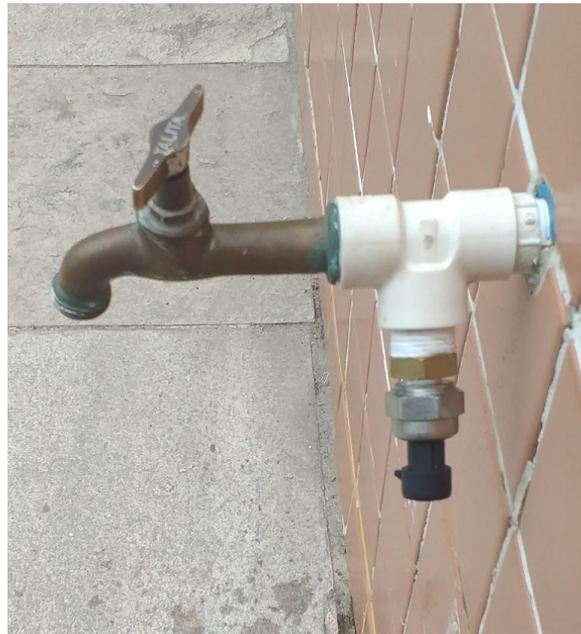
**Figura 04 : Modo de instalação do sensor de pressão na torneira de jardim**
