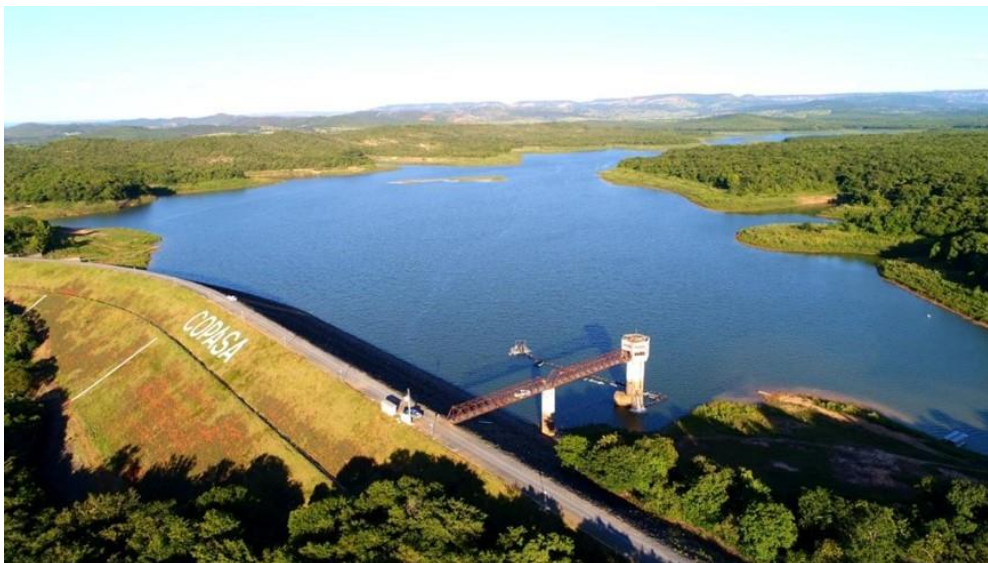
Figura 01 - Barragem Juramento, no município de Juramento/MG.
