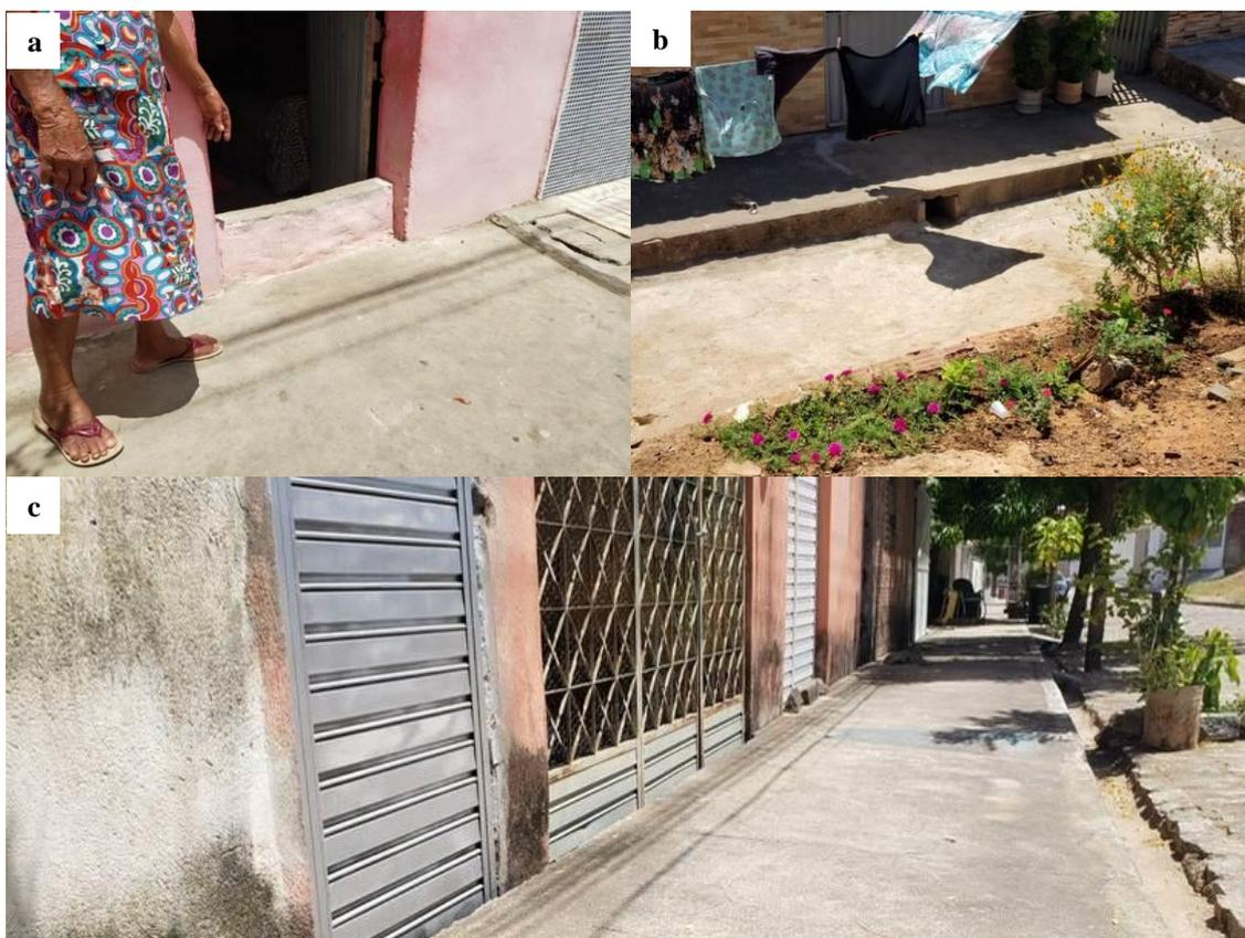
**Figura 5: (a) Barreira em porta de residência no município de Casserengue/PB, (b) canaleta de escoamento de águas pluviais e (c) elevação de calçadas no município de Marizópolis/PB**
