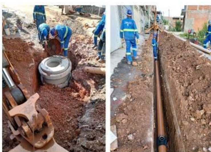
Figura 6 – Fase de execução das obras de ligações de esgoto
