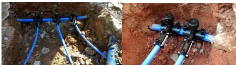
Figura 4: Metodologia utilizada na execução da ligação – eletrofusão, evitar fraudes
