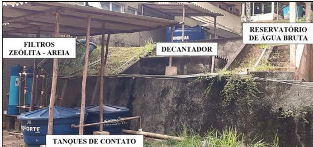
**Figura 1. Configuração das unidades da Salta-z instaladas nas dependências da UFV.**
