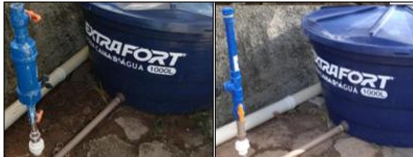
**Figura 2. Dosador de cloro (esquerda) e dosador de coagulante (direita), ambos utilizados para desinfecção no presente estudo.**
