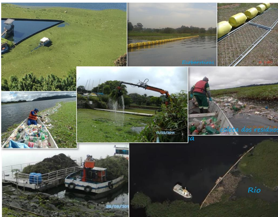
Figura 2: Detalhes da Barreira de contenção na captação retendo macrófitas, em afluente da represa, constituição da barreira com material flutuante e gradio, barcos de remoção e coleta manual de detritos.
