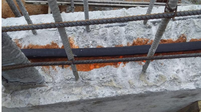
**Foto 1: Utilização de fita hidroexpansiva na vedação das juntas de concretagem**
