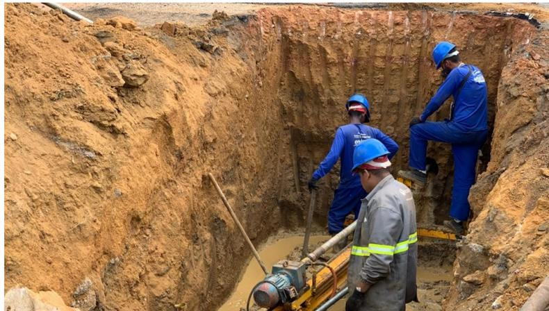
**Foto 2: Furo direcional utilizando método não destrutivo**
