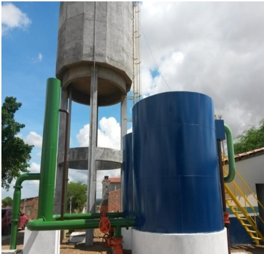
Figura 01 – Estação de tratamento em aço carbono padrão EMBASA – Filtração Direta Ascendente
