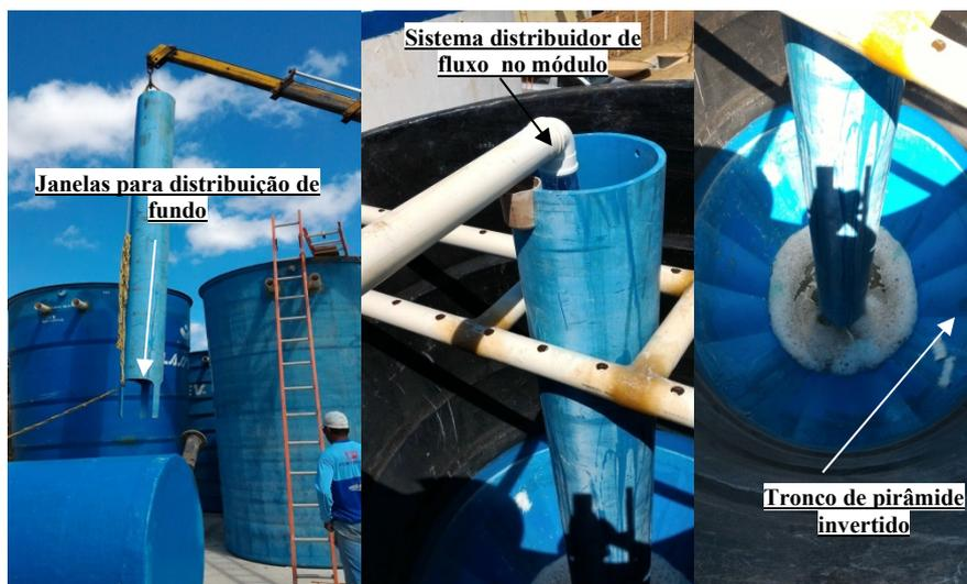
Figura 02 – Estrutura de distribuição do fluxo nos floco-decantadores e Tronco de pirâmide invertido
