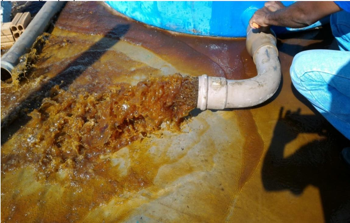
**Figura 06 – Descarga de lodo do floco-decantador**
