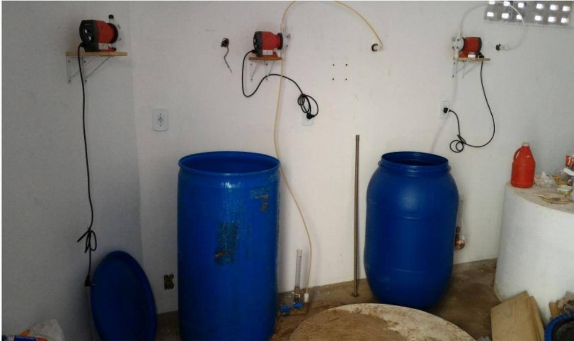
Figura 03 – Sistema de preparo das soluções químicas, tanque de preparo através do reuso de bombonas utilizadas para armazenar azeítonas.
