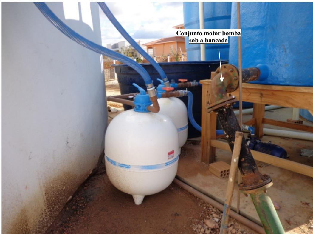
Figura 04 – Unidades de filtração reutilizadas e sob a bancada da unidade de mistura o conjunto motor bomba recuperado no Núcleo de Seabra.
