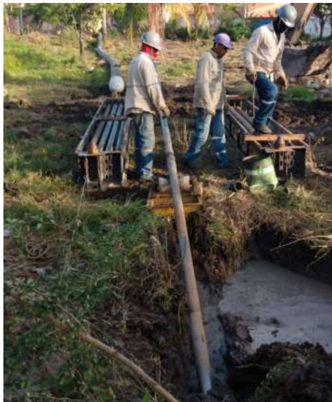
Figura 3 – Retirada das barras de ferro após completar o trajeto
