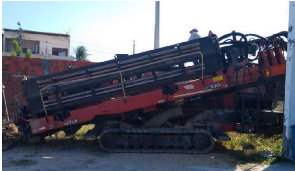
Figura 2 - Instalação da máquina perfuratriz
