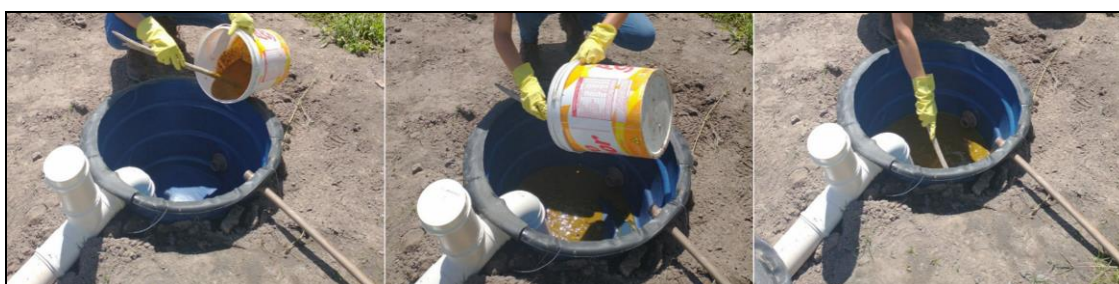
Figura 3. Adição de esterco bovino fresco na Fossa Séptica Biodigestora (FSB). Fonte: Autoria própria (2022).
