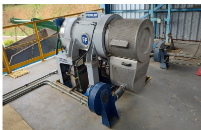
Figura 5: Lodo ETE Nova Contagem - desidratado em centrífuga.
