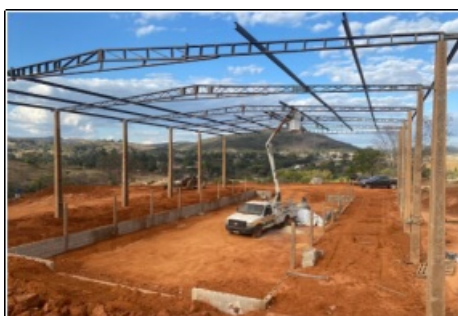
Figura 12: Vista da construção do galpão.
