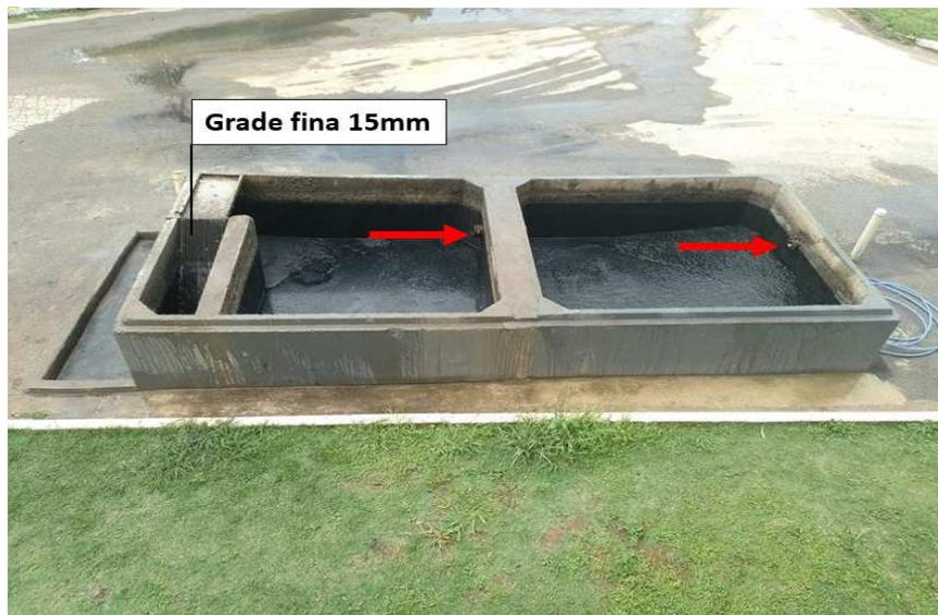
**Figura 1: Sistema de pré-tratamento de lodo séptico.**
