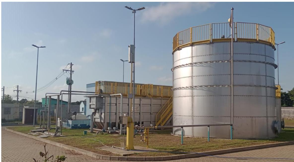
**Figura 2: Visão geral da ETE VP exibindo o bloco hidráulico confeccionado em aço inoxidável. Nota-se que a estação apresenta uma configuração compacta.**
