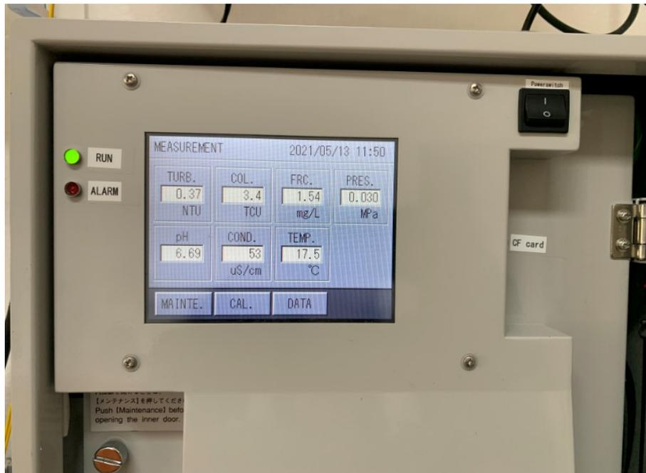
Figura 02 – Resultado físico-químico (pH, cor aparente, turbidez, cloro residual livre e condutividade) on line visualizado no equipamento
