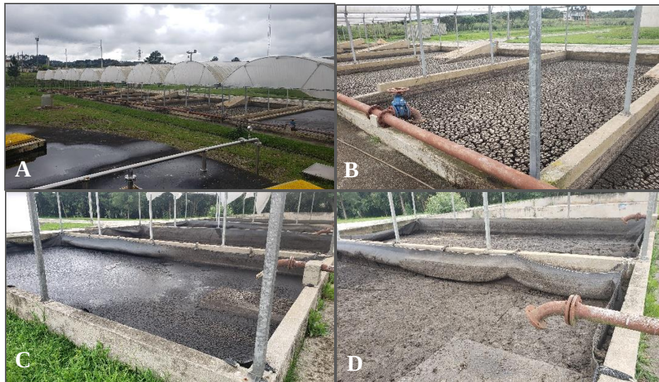
Figura 2: Leitos de secagem de lodo aeróbio (A e B) e anaeróbio (C e D) em matriz de tratamento com reatores UASB e Filtro Biológico Percolador de baixa taxa, localizada na região sul do Brasil.
