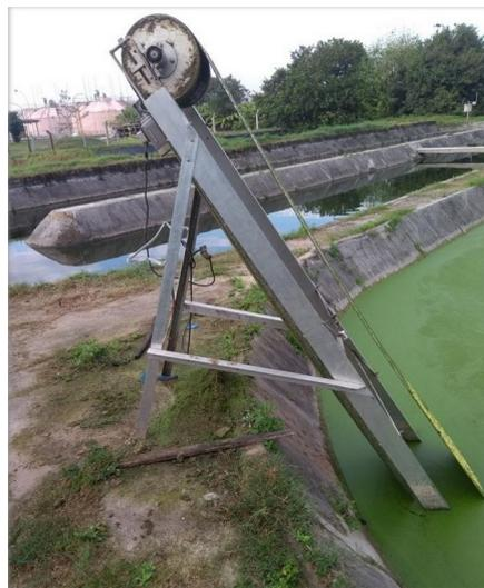
**Figura 3: Registro fotográfico da esteira retiradora de macrófitas, instalada ao final da LM.**
