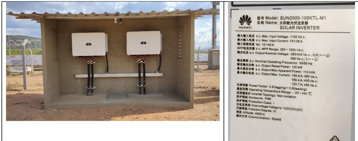
**Figura 6 – Disposição dos Inversores**
