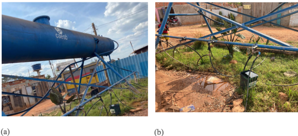
Figura 1. (a) Distribuidora de água potável ou chafariz na Chácara Santa Luzia. (b) Mangueiras improvisadas conectadas ao chafariz.
